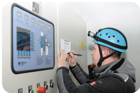
Ein GAIA-Fachmann für die technische Betriebsführung erfasst die Daten einer Windenergieanlage.
