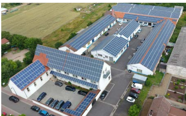
Das Firmendomizil von GAIA: Ein Energiegewinn-Altbau mit Vorbildcharakter
